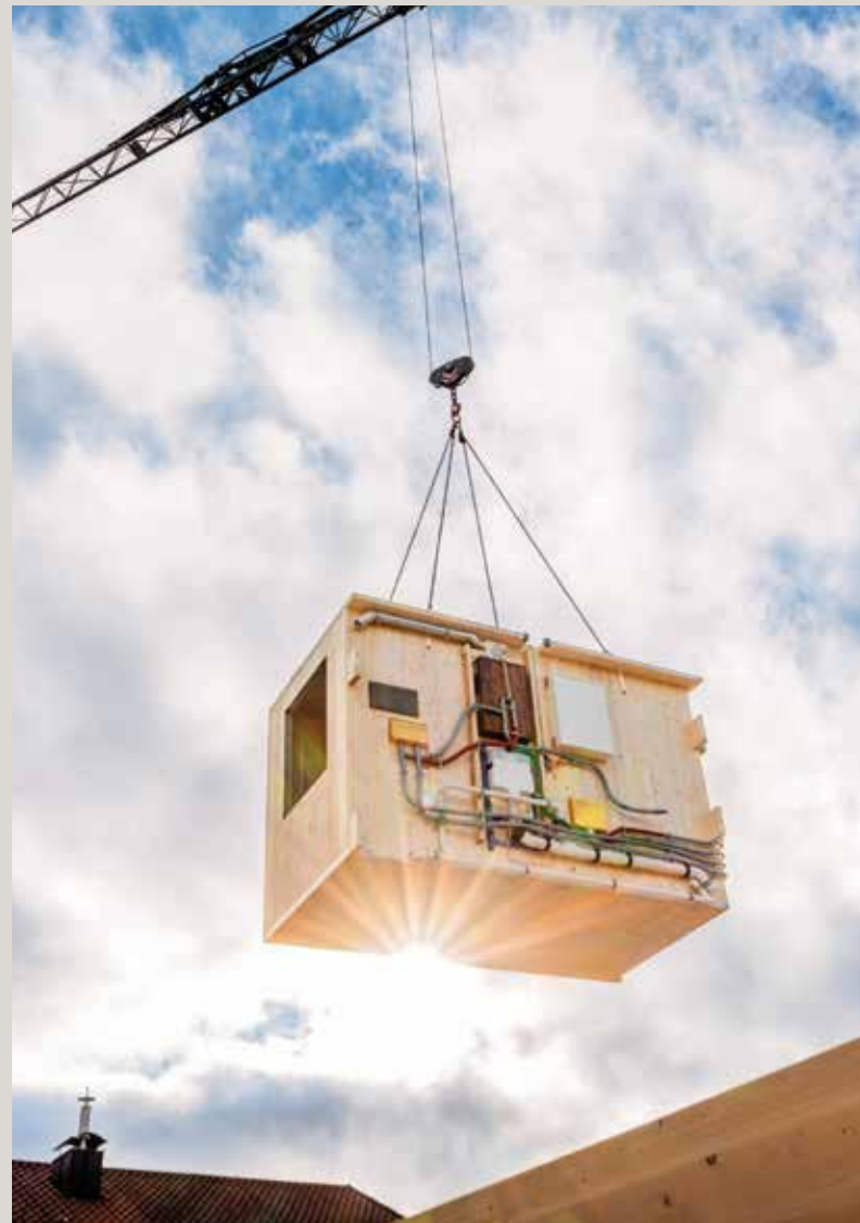
__ Die Modulbäder werden vorgefertigt angeliefert, per Kran präzise eingehoben, fachgerecht montiert sowie angeschlossen.
